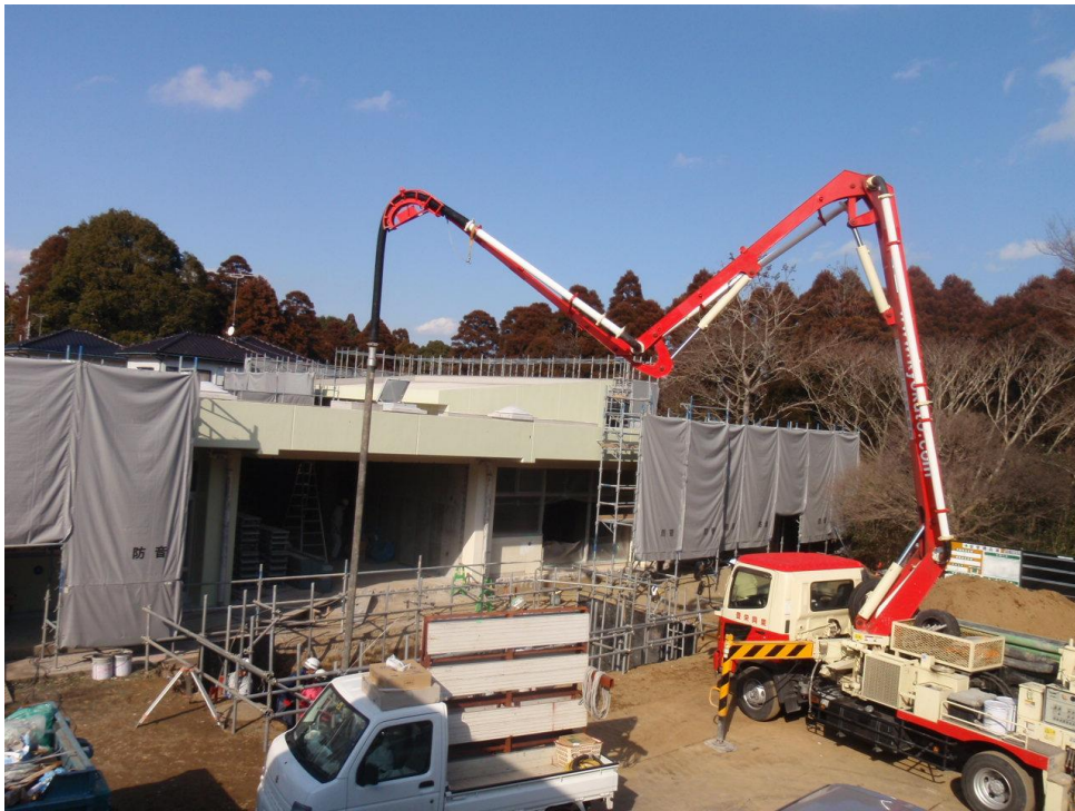
工事中の九十九里ホーム飯高デイサービスセンター
