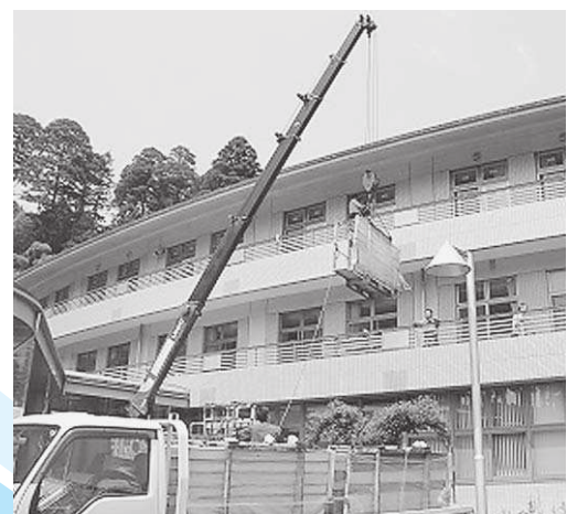
複層サッシの設置工事（日向の里）
