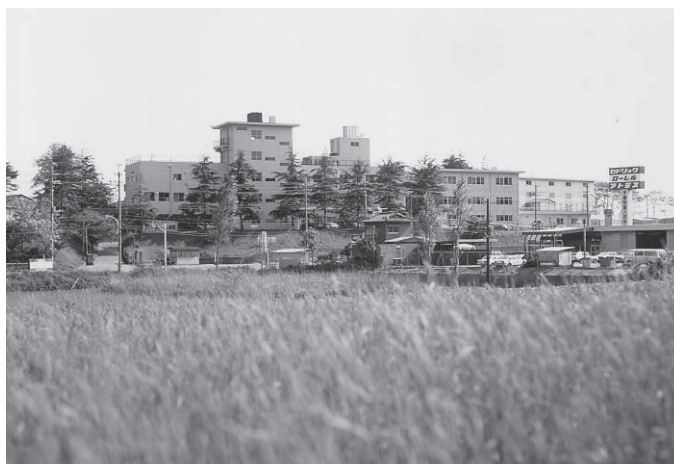
リハビリテーションセンター完成時の九十九里ホーム病院
