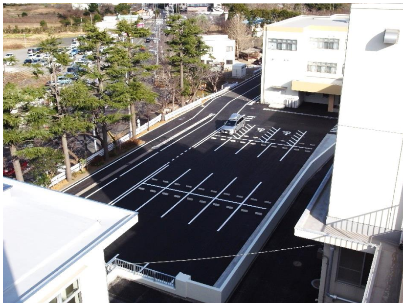
北側駐車場全景
